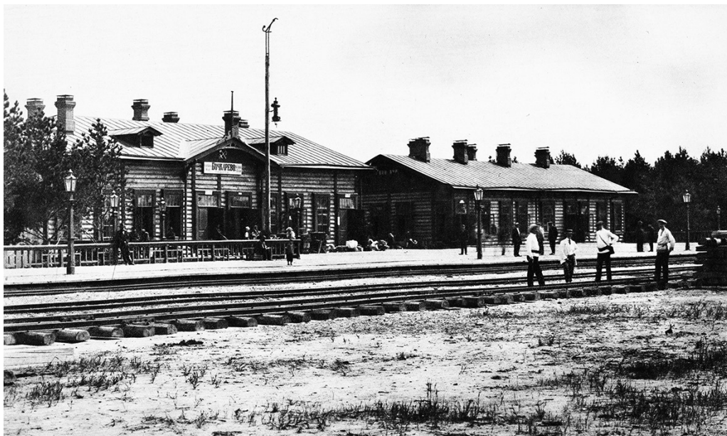
Станция Бочкарёво (ныне Белогорск), здание вокзала. 1910–1914 гг.
